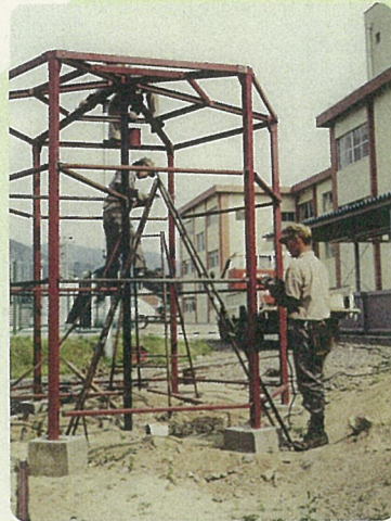
小鳥小屋建設
